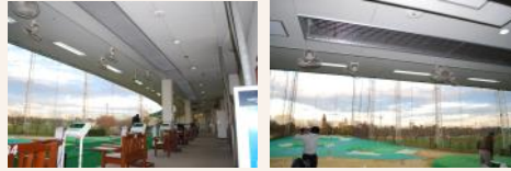
アコーディア・ガーデン東京ベイの天井遠赤外線ガス暖房機
