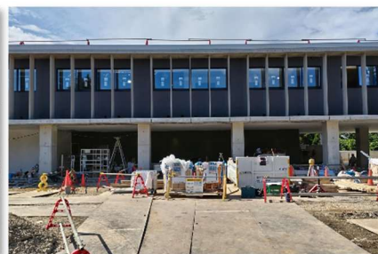
工事中のクラブハウス 正面側から
