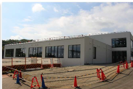
工事中のクラブハウス コース側から
